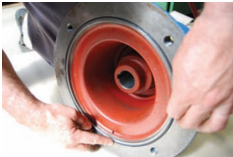
Abb. 31: O-Ring in die vorgesehene Nut eingelegt
